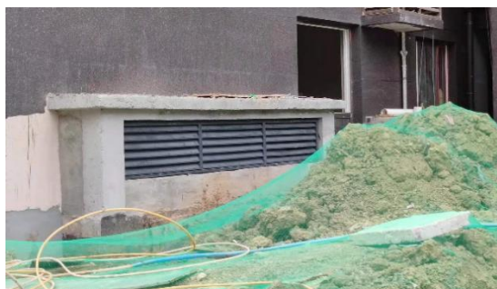
备用发电机排气筒
